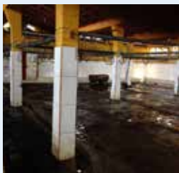
2. Lavado de restos de la sala de sacrificio
