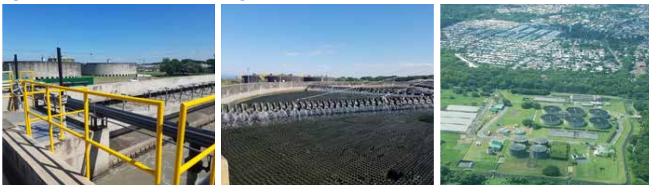
Figura 10. Planta de Tratamiento de Managua
